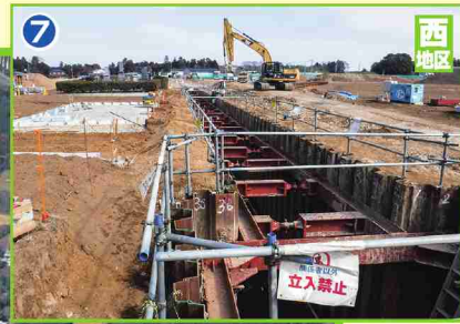
供給処理施設敷設工事 (雨水管敷設工事)
