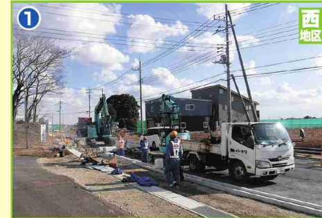
道路築造工事 (国道土浦稲敷線)
