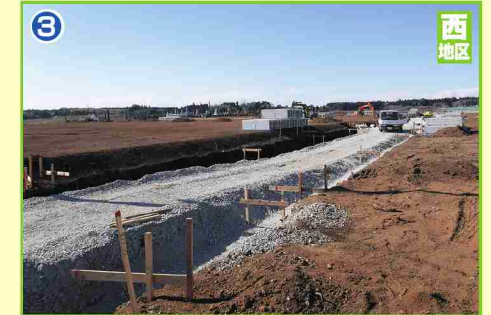
進む造成・道路築造工事
