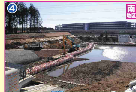
第3調整池築造工事
