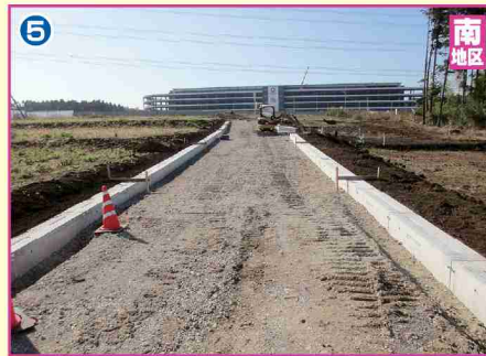
道路築造工事
