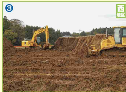
一次造成工事
