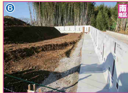
宅地整備工事(擁壁)
