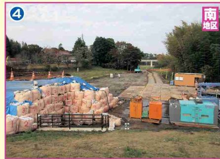
調整池堤体整備工事
