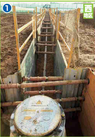
汚水管敷設工事
