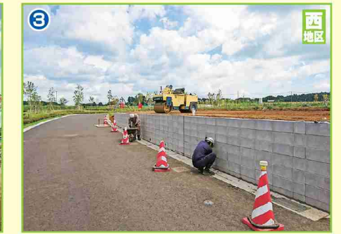
3 宅地整備工事(擁壁工事)
