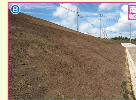
8 緑地法面工事
