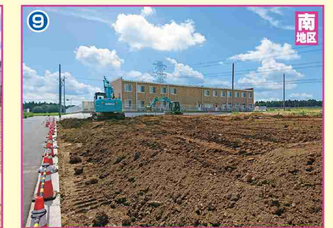
9 宅地整備工事
