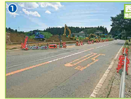
1 街路改良工事(県道土浦稲敷線)
