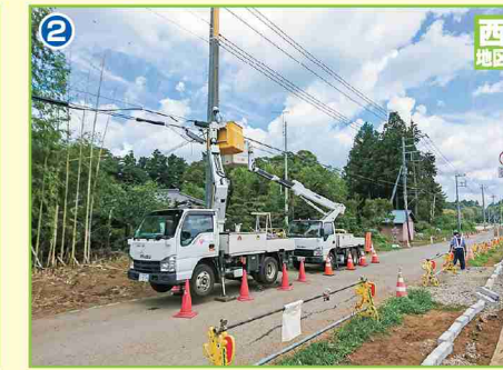
2 進む『阿弥陀堂』周辺工事
