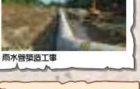
雨水管築造工事
