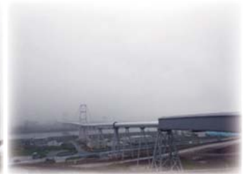
気仙川を横断し土砂を運搬
