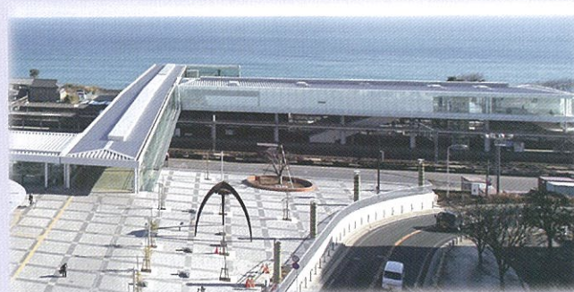
【日立駅自由通路・橋上駅舎の整備】
