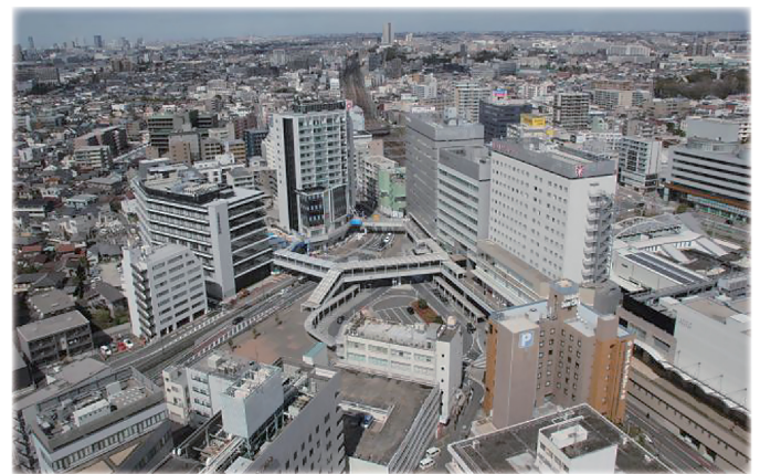
千葉駅西口地区再開発全体写真
