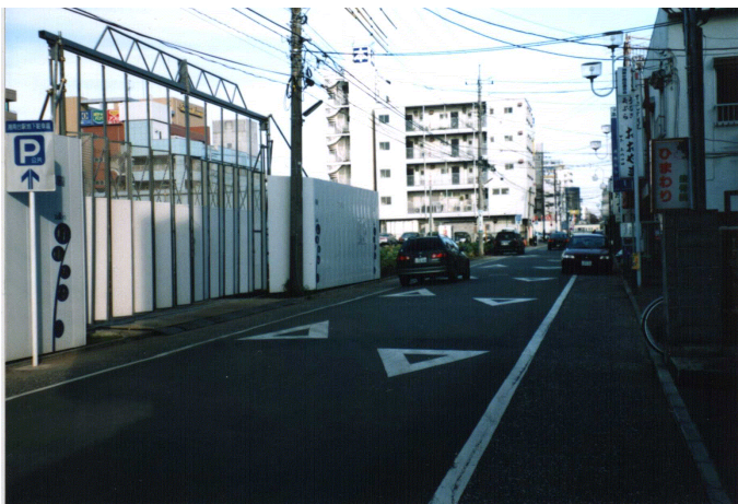
写真3 連続波形舗装とイメージ舗装
