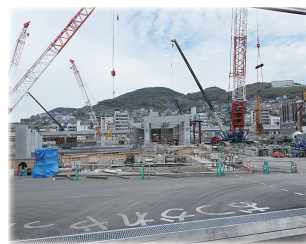
スタジアム建設現場
