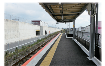
車両基地と車両基地駅ホーム
