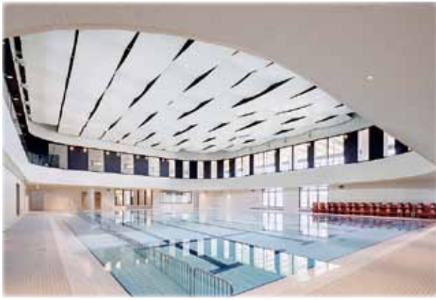
温水プールの全景。減災を考慮し膜天井を採用。
