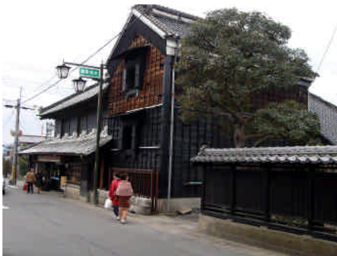
潮田家住宅・見世蔵 / 明治43年
