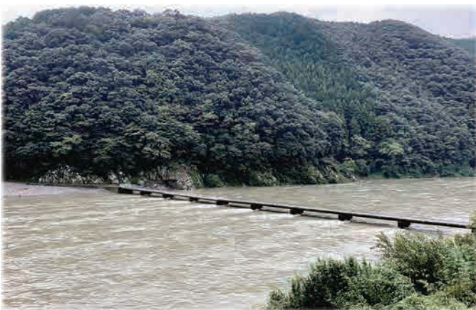
岩間沈下橋（10/23撮影、前日の降雨で橋桁近くまで増水）
