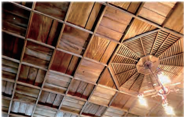
「ゆすはら座」の外観・天井写真
