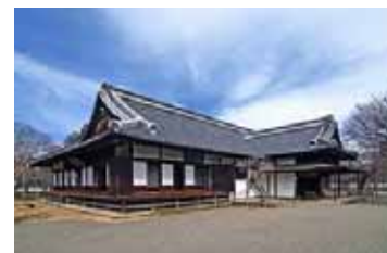
弘道館(水戸市)
