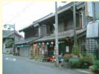
景観重要建造物のイメージ
