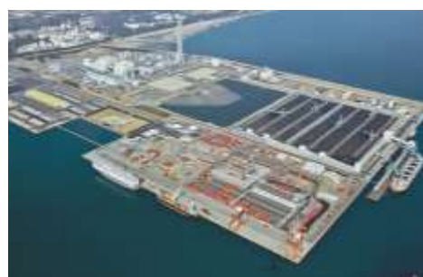
(株)JERA常陸那珂火力発電所と揚炭バース
