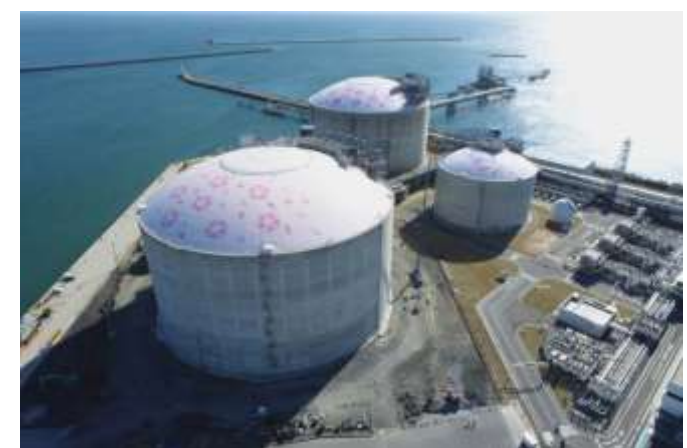
LNG基地 2号タンク令和3年3月より運転開始 (東京ガス(株)HPより引用)
