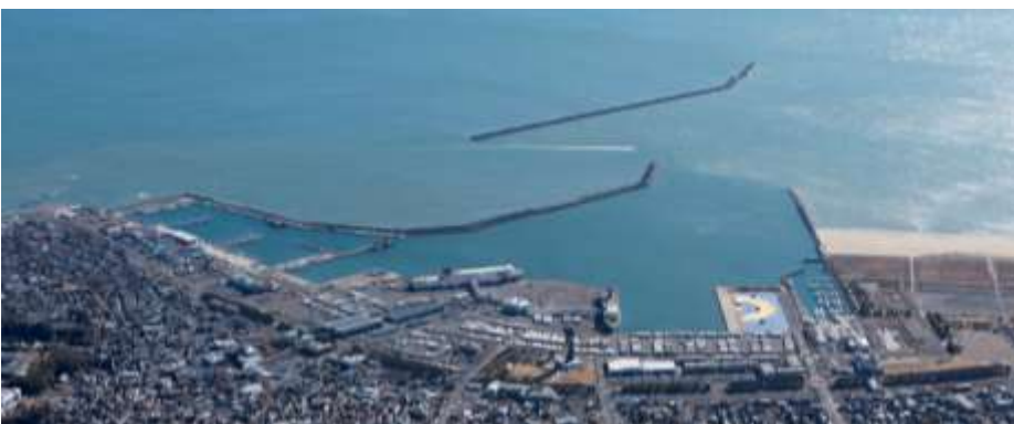
防波堤（大洗港区）
