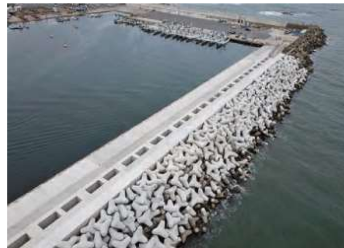
大洗港区 南防波護岸津波高潮対策 出典：日本埋立浚渫協会HP
