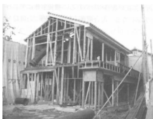
② 1～2階外壁撤去
