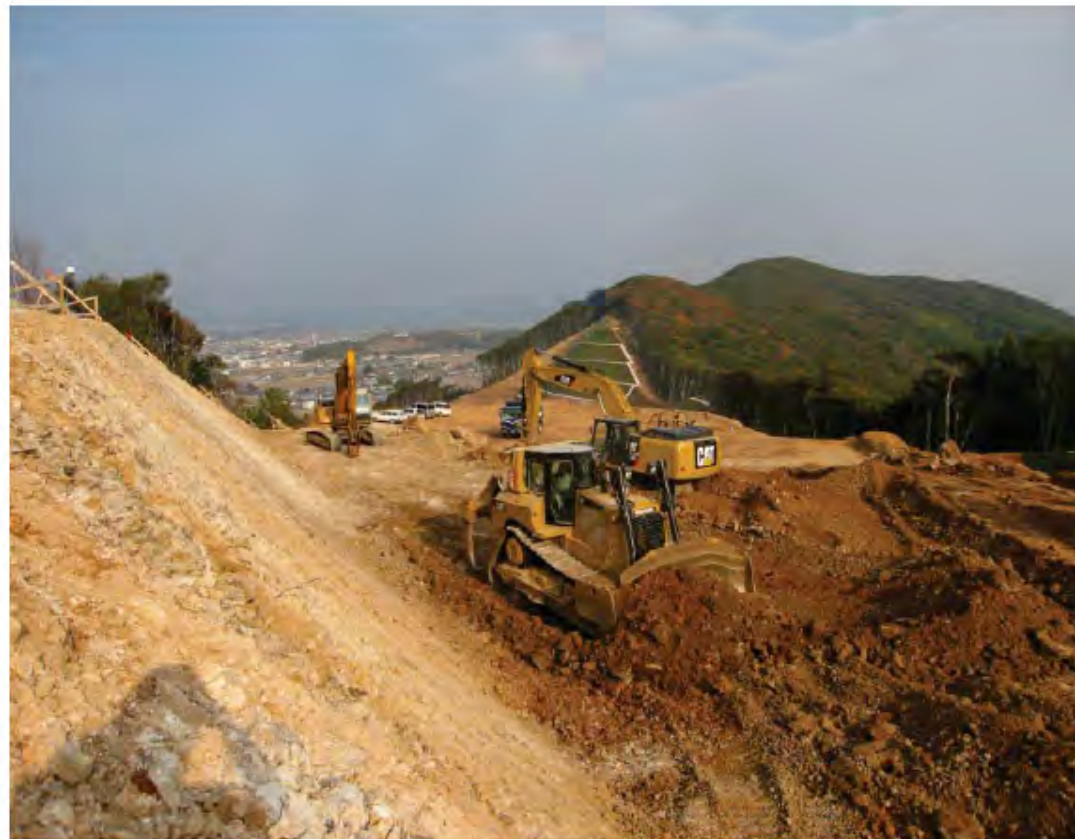
掘削(切土)施工中
