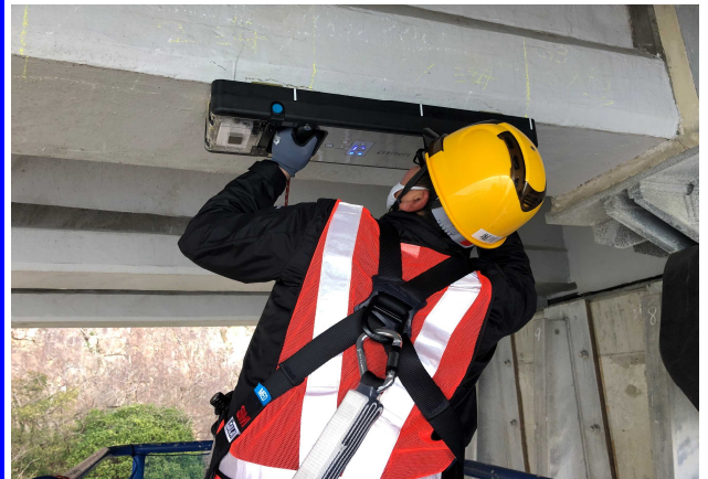
橋梁点検車による検査風景
