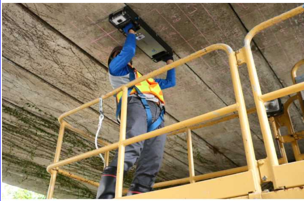
橋梁点検車による検査風景
