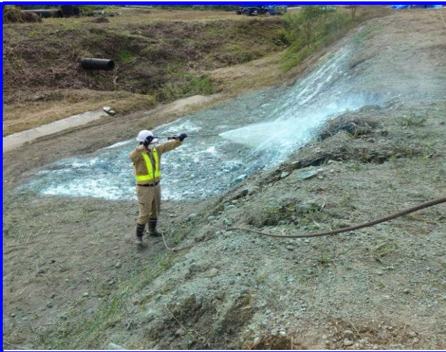
処分場内法面に施工
