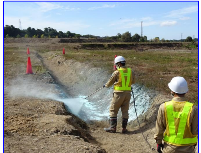
処分場内雨水側溝に施工
