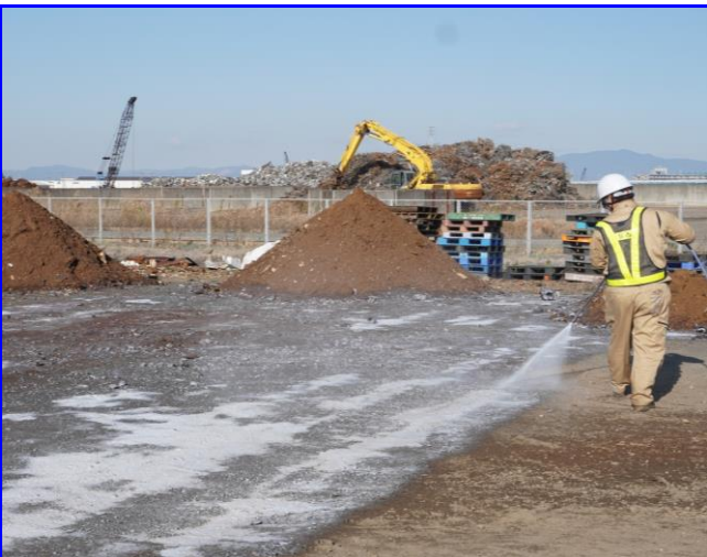
作業現場内平面に施工
