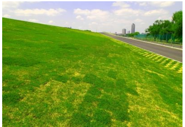
pH11の荒川堤防法面に散布後、2か月後の野芝の状況
