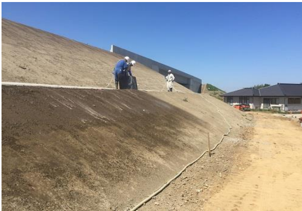
圏央道坂東常総改良その2工事 散布状況
