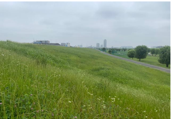
荒川堤防8年後(2022年6月)の状況
