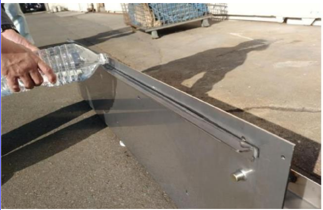
浸透水侵入防止板漏水試験(床版劣化防止対策)
