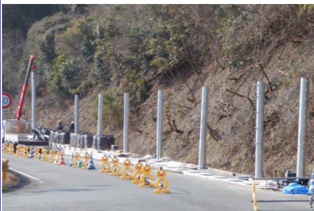
支柱建て込み状況
