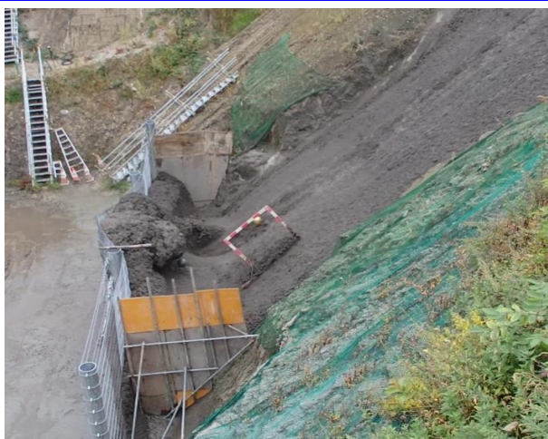
土砂流下実験状況
