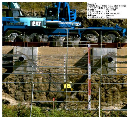
重錘衝突実験状況
