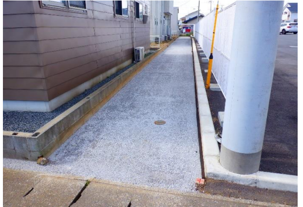
(仮称)鹿嶋市宮中地内歩道維持トライアル工事
