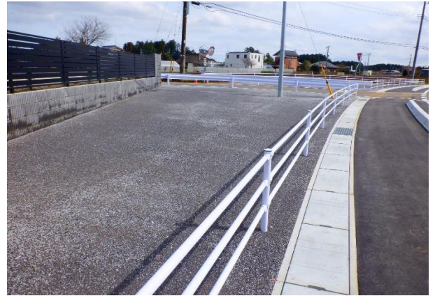
02国補地道第02-03-544-0-002号 31国補地道第31-03-544-0-001号合併 道路改良舗装工事(その2)
