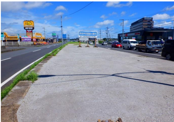
配水管布設工事(3工区) ※国道124号線
