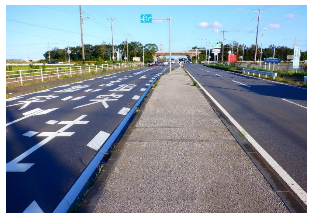
30県単道修 第30-57-644-0-002・003・004・005号 道路舗装修繕工事
