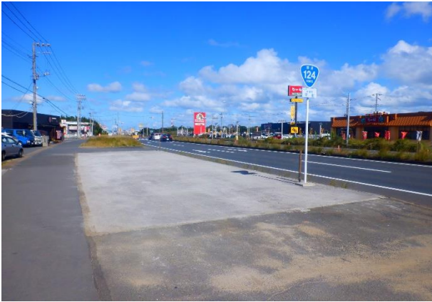
04県単道修第04-57-604-0-001号道路維持修繕工事
