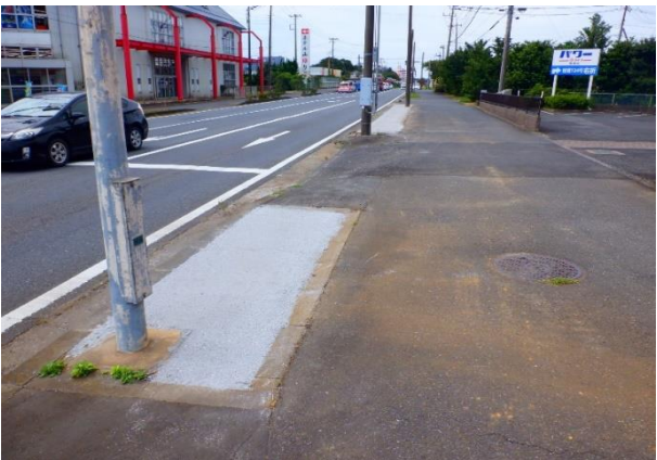
(仮称)鹿嶋市平井地内防草対策トライアル工事
