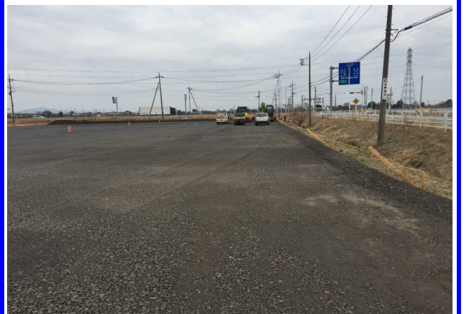
施工例②: 下層路盤材
