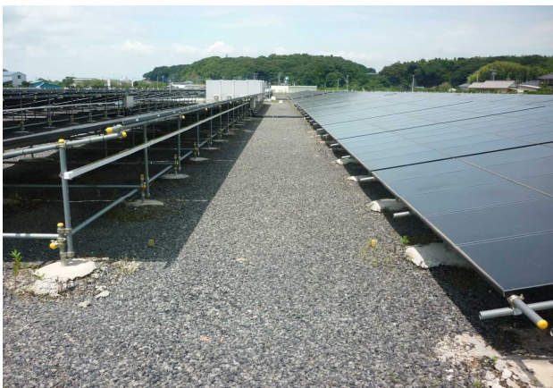
施工例①: 太陽光発電施設の敷き均し材
