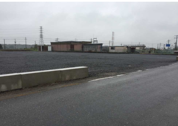
施工例③: 駐車場敷き均し材
