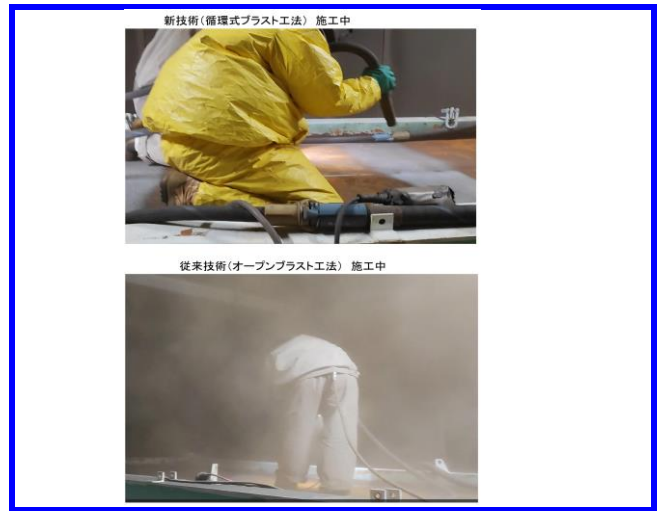
ブラスト施工時の粉じん発生状況比較
