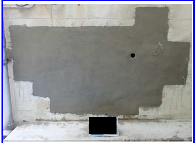
施工完了(断面修復工)
