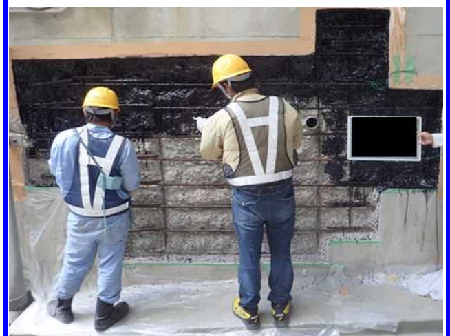
施工状況(樹脂塗布状況)
