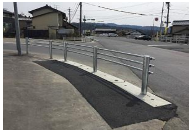
施工実績②
