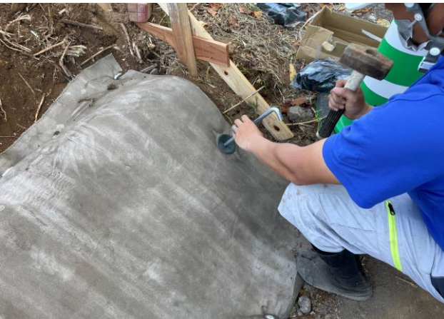
施工状況② アンカーピン打設
