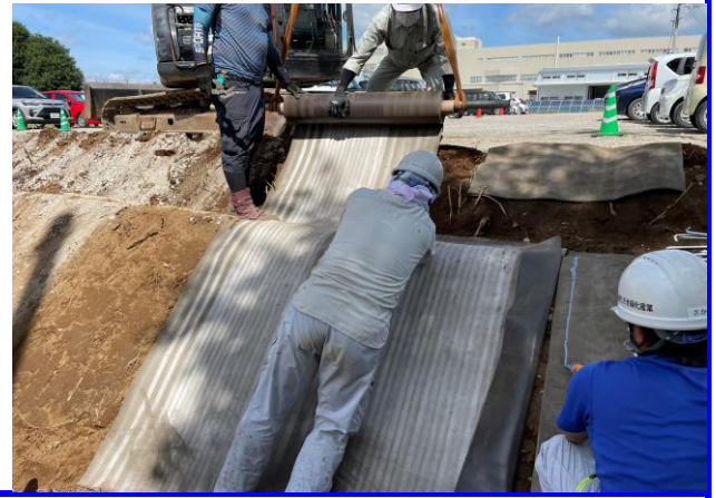
施工状況① コンクリートキャンバス敷設
