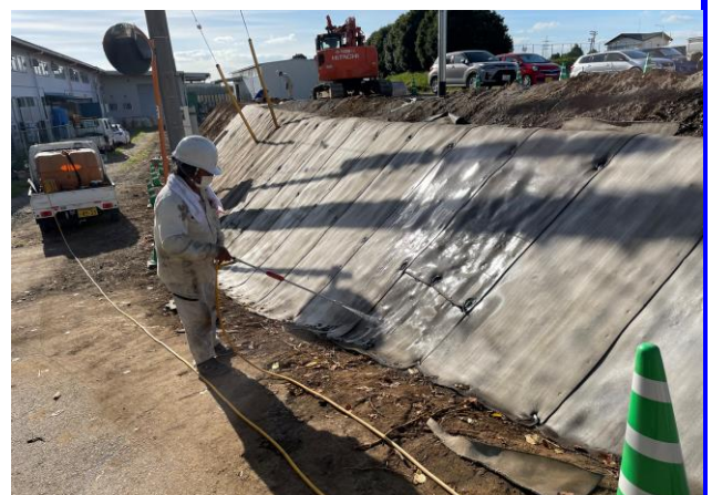
施工状況③ 散水
