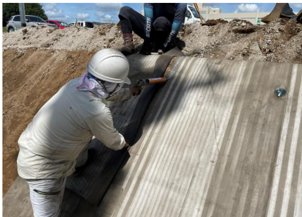
施工状況④ 端部処理
