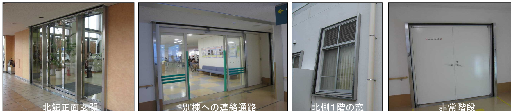
止水板のための角落しとの設置
