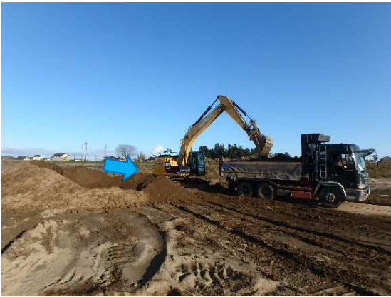
河道内の土砂掘削事例
