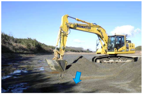
河道内の土砂掘削事例
