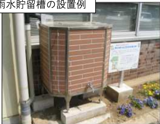
雨水貯留槽の設置例
