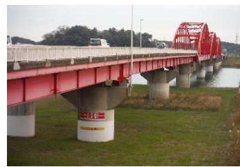
カメラによる水位標の監視
