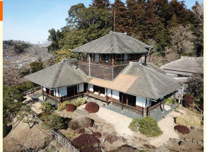
好文亭空撮（耐震補強後）
