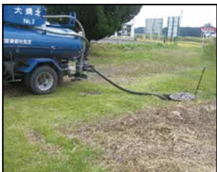
農集排の汚水受け入れ状況 (那珂久慈流域・大宮ポンプ場付近)
