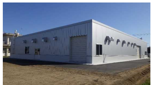
内水面支場魚類飼育実験棟新築工事
