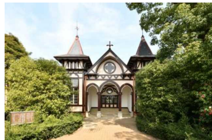
旧土浦中学校本館耐震補強工事
