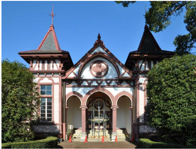
【正面外観(着工前)】
