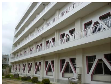
日立第二高校普通特別教室棟耐震補強工事
