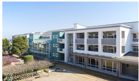
土浦第三高校管理・普通教室棟改築工事
