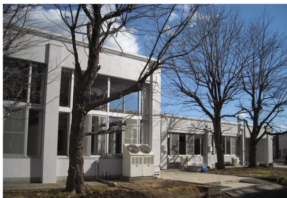
デイケア施設(耐震補強他工事)
