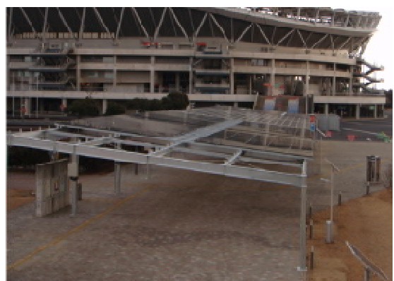
カシマサッカースタジアム太陽光発電設置工事
