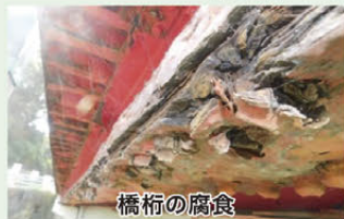
橋桁の腐食
