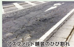
アスファルト舗装のひび割れ
