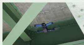
ドローンによる橋梁点検
