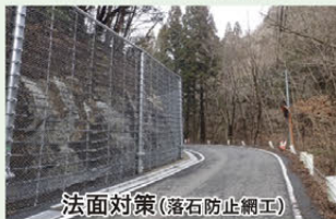
法面対策(落石防止網工)
