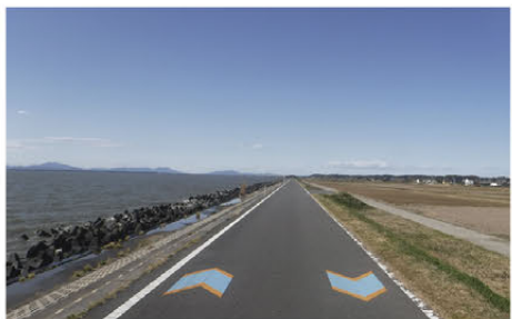
矢羽根の設置
