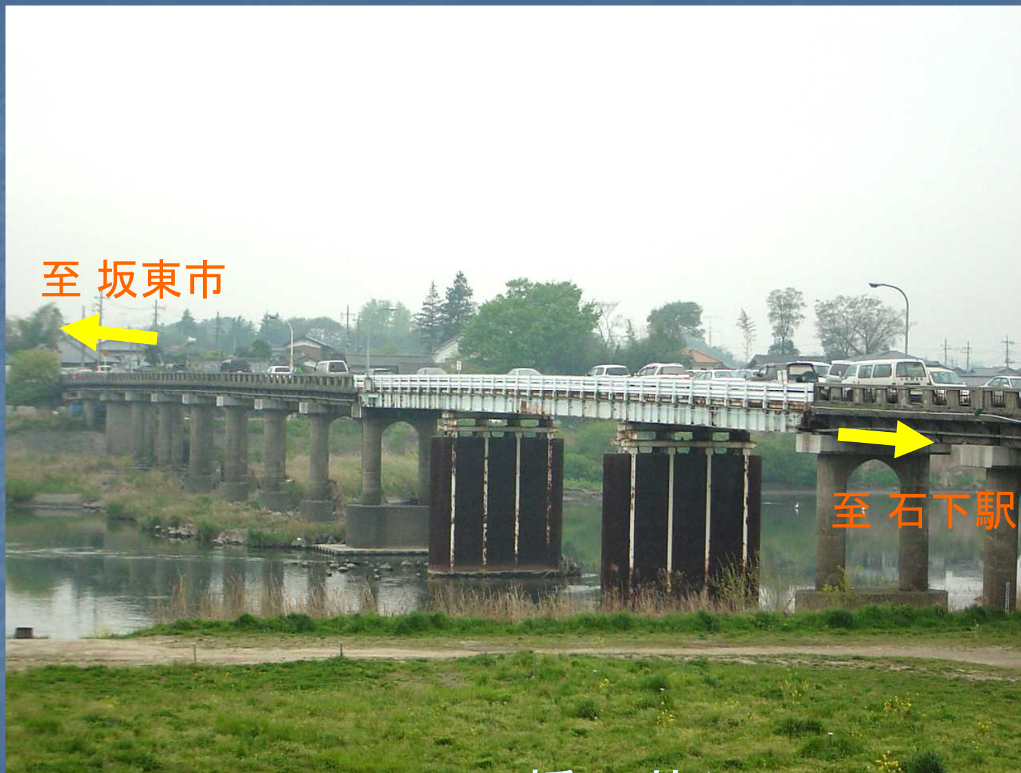
旧石下橋の状況
