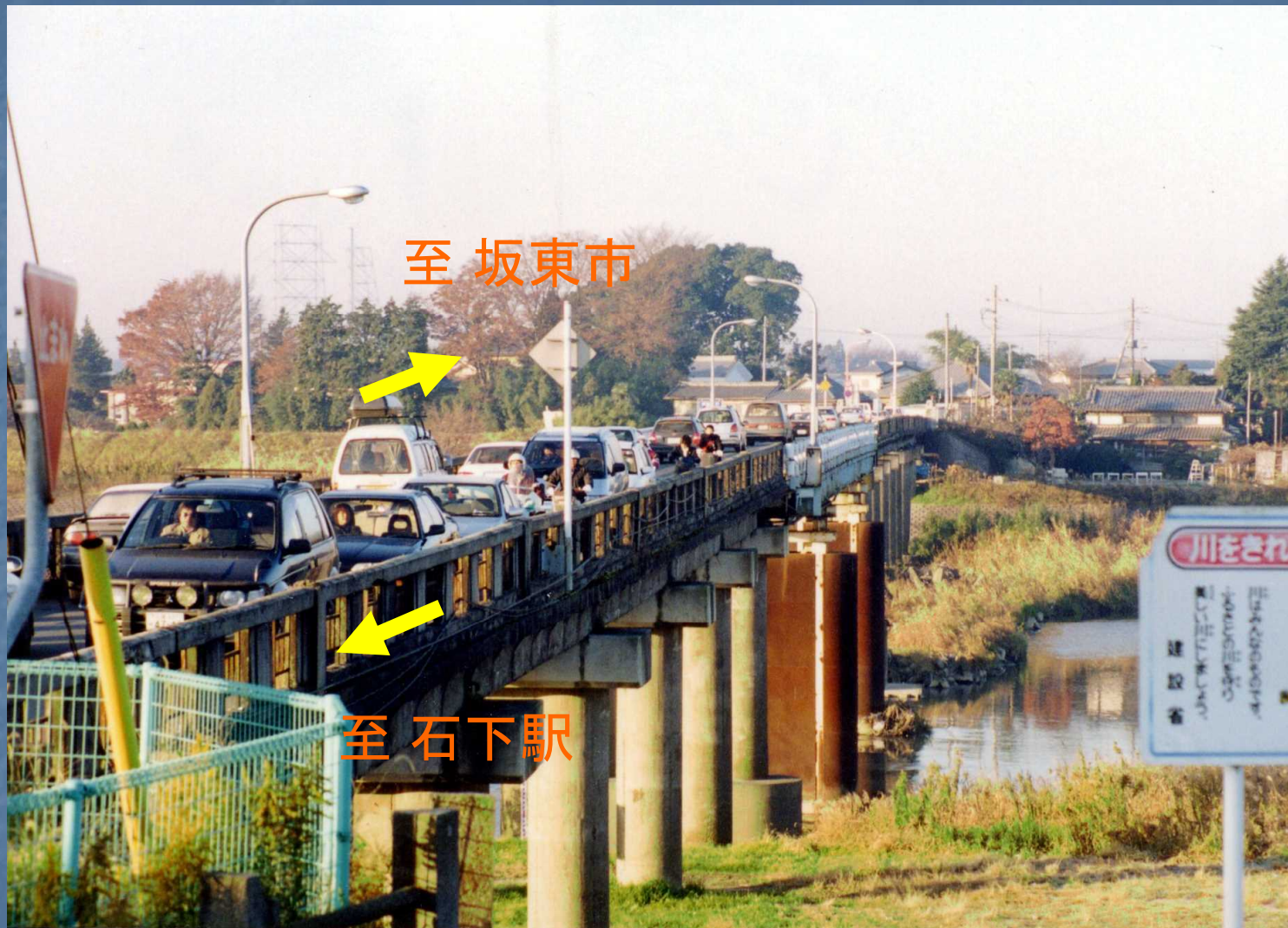
旧石下橋の状況
