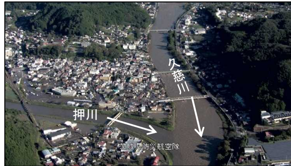
久慈川流域（県管理区間）（大子町） 全壊：35棟、半壊413棟、一部損壊：137棟
