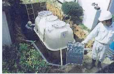
高度処理型浄化槽の設置
