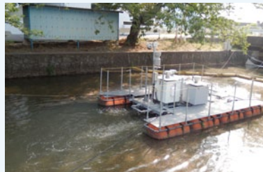
アオコ抑制装置の設置
