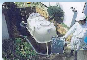
高度処理型浄化槽の設置
