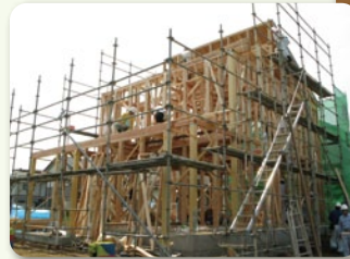
県産材を使った住宅の建築
