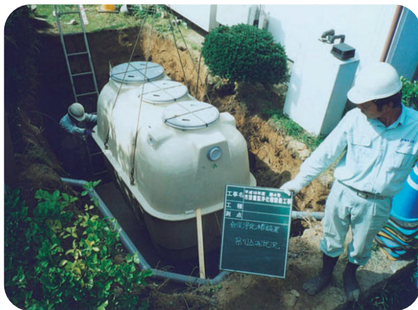
高度処理型浄化槽の設置
