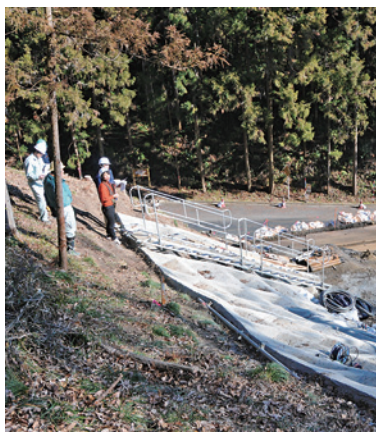
法面の復旧工事（常陸大宮市）
