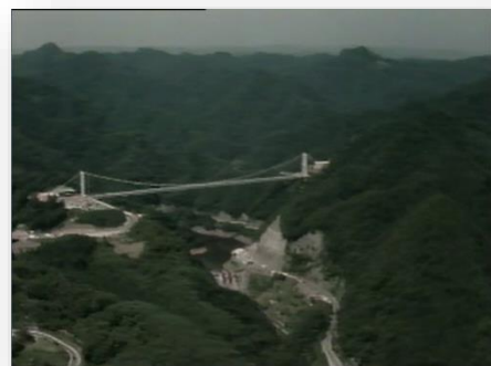
竜神大吊橋竣工
