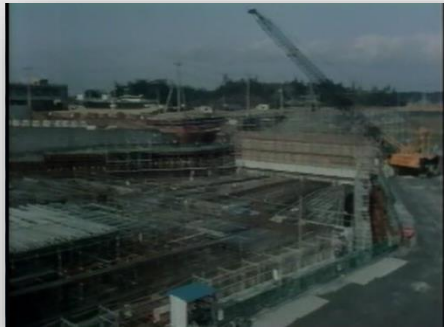
建設中の那珂機場
