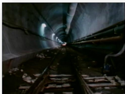
霞ヶ浦用水 筑波トンネル
